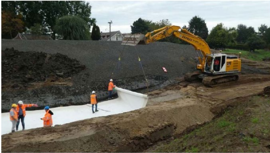
Figuur 5-1: Aanbrengen bentonietmat (waterschap Limburg)
